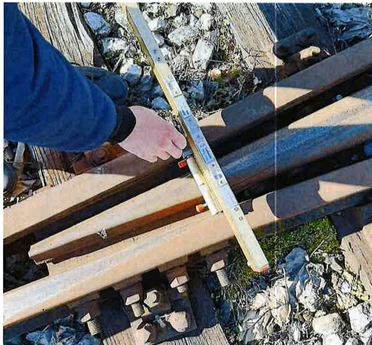
Slika 6. Mjerenje širine na skretnici
