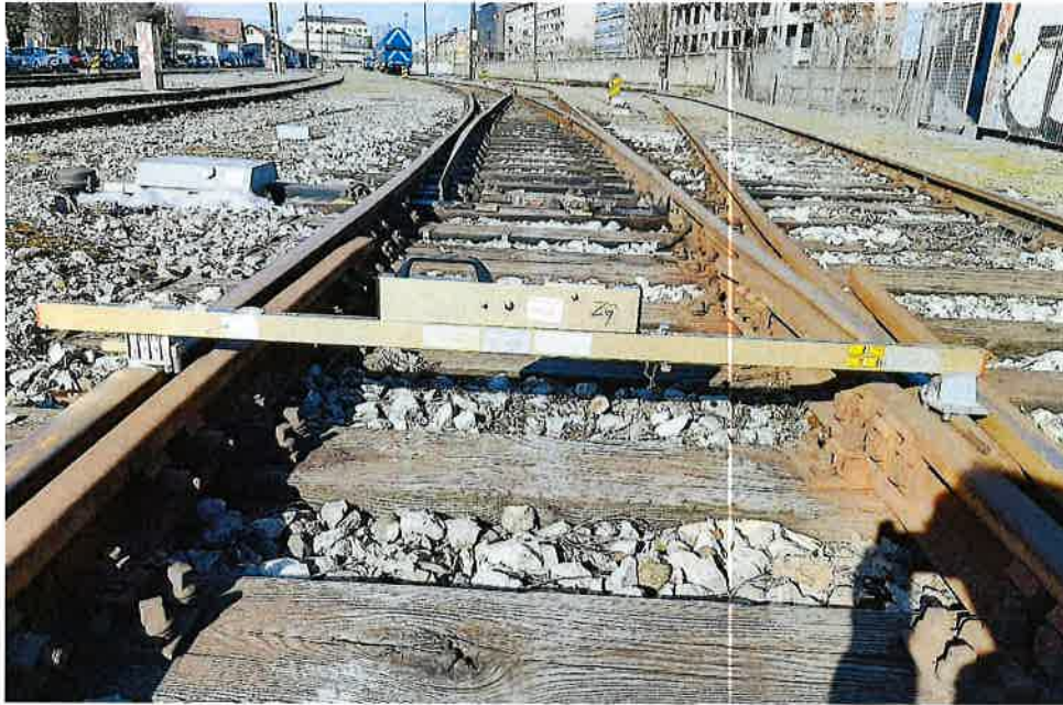
Slika 5. Mjerenje udaljenosti na skretnici
